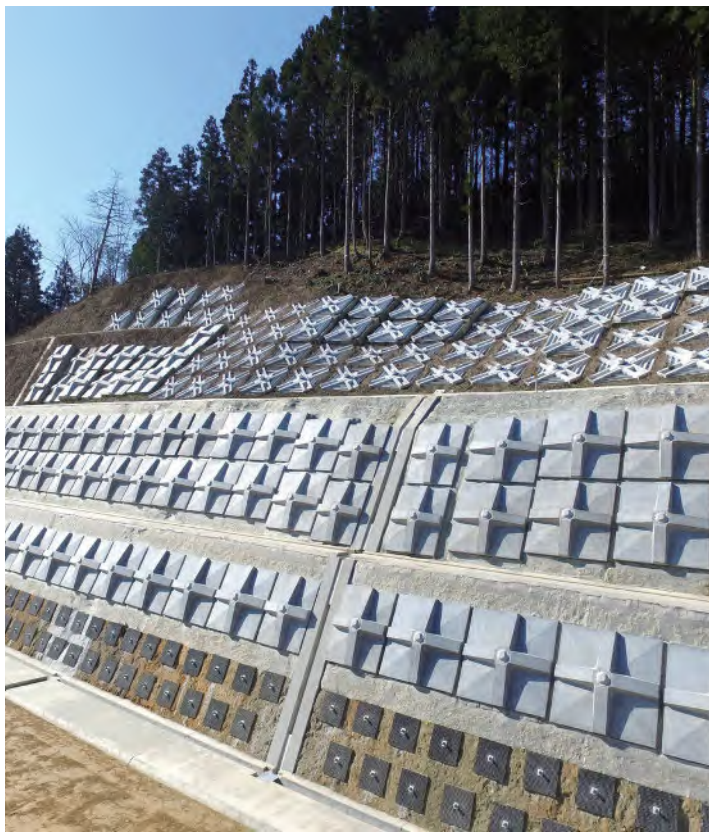
PCフレーム:HS300-45他(福井県永平寺町)
