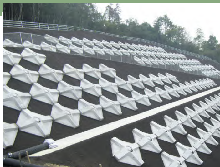
PCフレーム:HSS250-35.40(岡山県浅口市)
