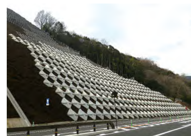
PCフレーム:HSS300-30、35、45(広島県呉市)
