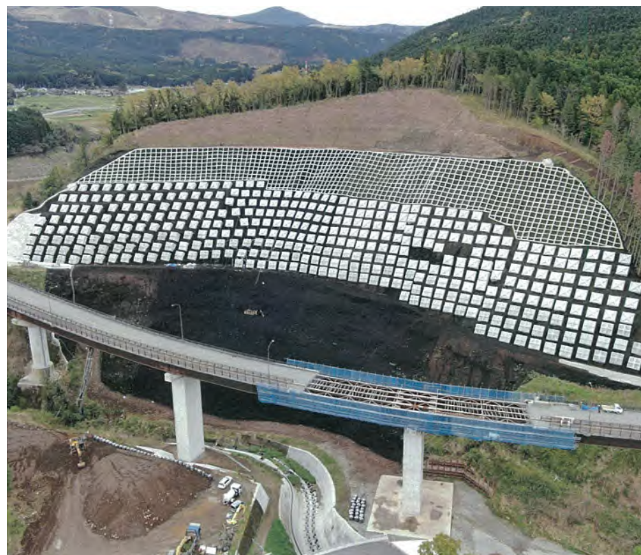
PCフレーム:TS300-50他(熊本県西原村・大切畑災害)
