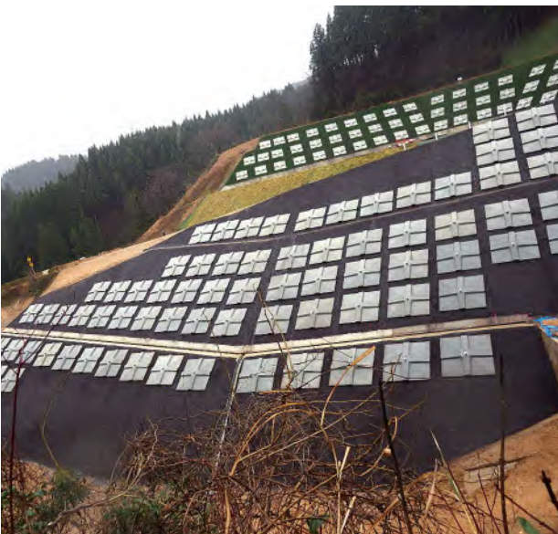
PCフレーム:HS300-35(富山県砺波市)
