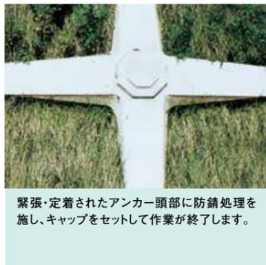
緊張・定着されたアンカー頭部に防錆処理を施し、キャップをセットして作業が終了します。
