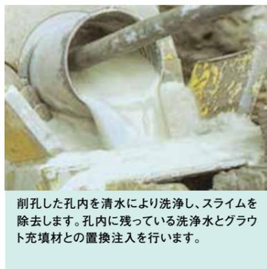
削孔した孔内を清水により洗浄し、スライムを除去します。孔内に残っている洗浄水とグラウト充填材との置換注入を行います。
