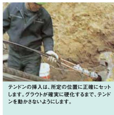
テンドンの挿入は、所定の位置に正確にセットします。グラウトが確実に硬化するまで、テンドンを動かさないようにします。
