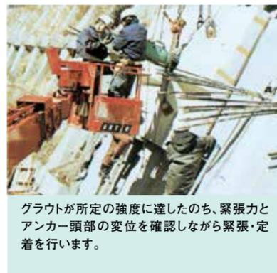
グラウトが所定の強度に達したのち、緊張力とアンカー頭部の変位を確認しながら緊張・定着を行います。
