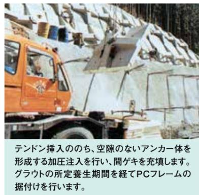
テンドン挿入ののち、空隙のないアンカー体を形成する加圧注入を行い、間ゲキを充填します。グラウトの所定養生期間を経てPCフレームの据付けを行います。
