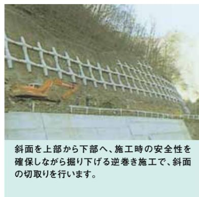
斜面を上部から下部へ、施工時の安全性を確保しながら掘り下げる逆巻き施工で、斜面の切取りを行います。
