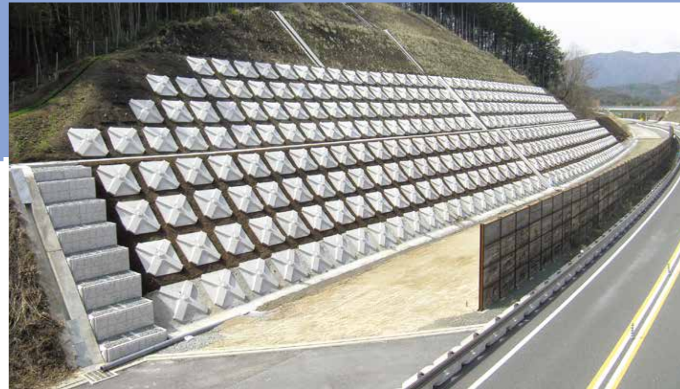
PCフレーム:HSS250-30(長野県飯田市)
