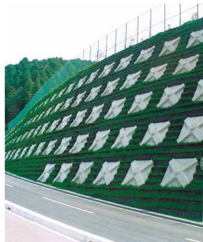
PCフレーム:HSS250-30(愛知県足助町)
