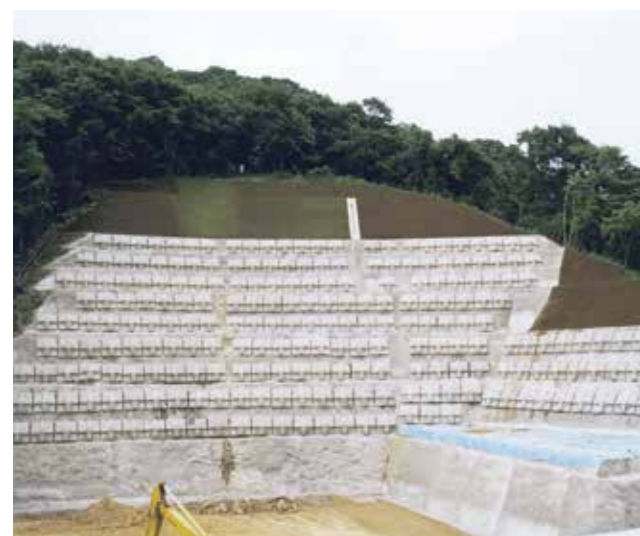
PCフレーム:S200-55(島根県美保関町)
