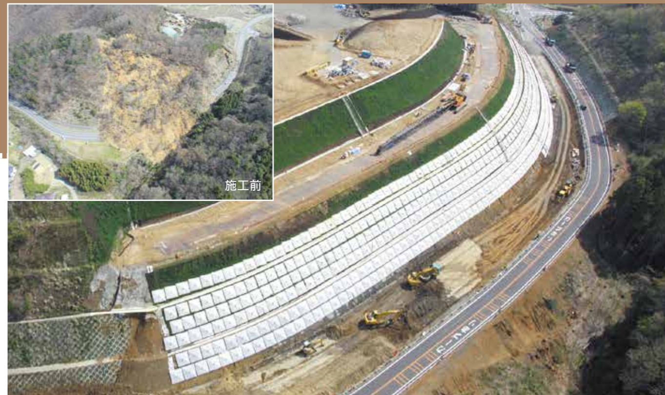
PCフレーム:BS300-40(福島県いわき市) 施工直後
