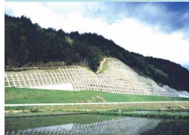
PCフレーム:C300-55(岐阜県大和町) 施工直後
