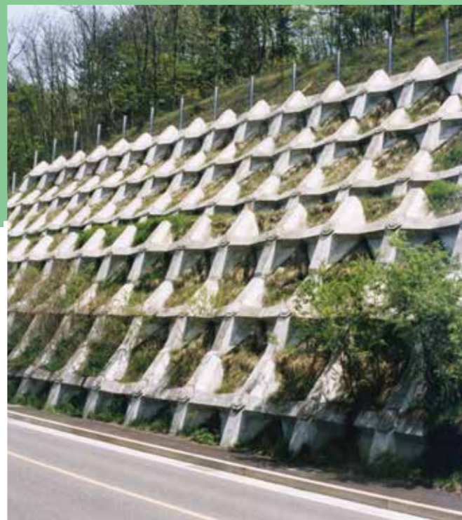
PCフレーム:SS300-40.45.50(長野県松本市)
