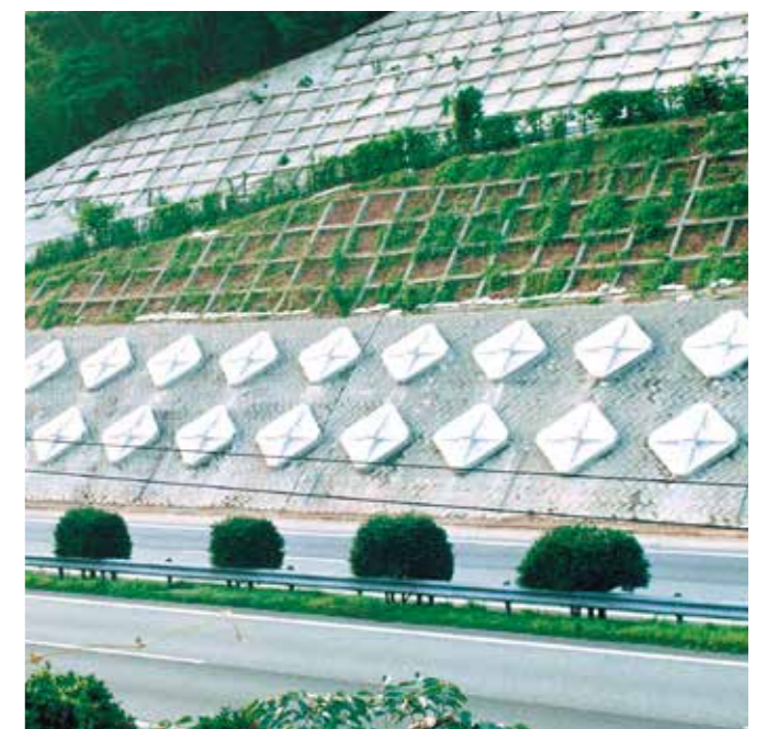
PCフレーム:SS300-35(福岡県北九州市)
