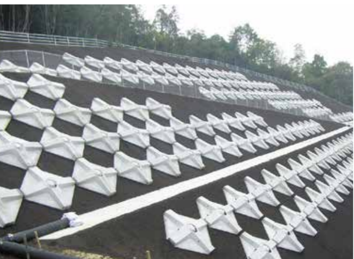
PCフレーム:HSS250-35.40(岡山県浅口市)
